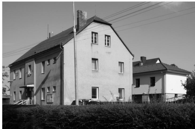
Budovy Obecního úřadu v Bohuslavicích (foto: Eva Ilková)
