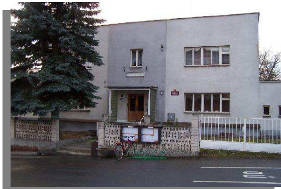
▼ Před a po rekonstrukci
