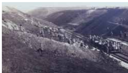
Výstavba železniční tratě Hlučín – Petřkovice (po roce 1920)
