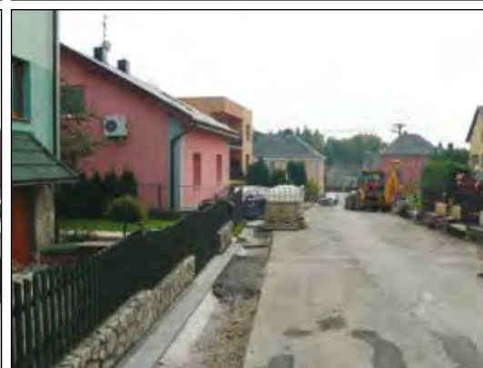
Rekonstrukce ul. Polní
