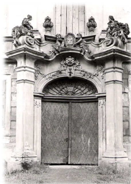
7) Zámek během oprav d) Hlavní portál zámku s původním erbem majitele Friedricha Pfeil
