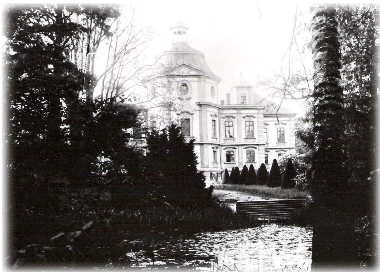
5) Zámek v roce 1935 a) Jižní strana zámku s kaplí
